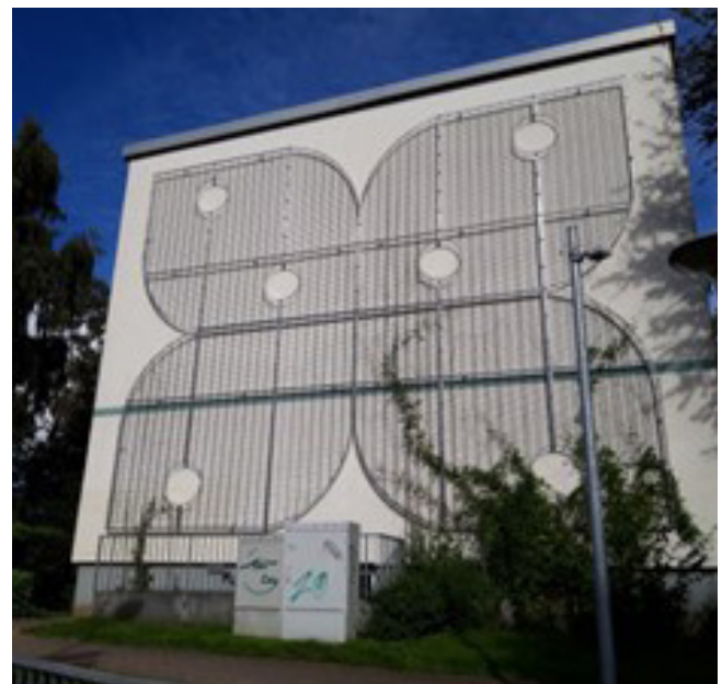
Estrutura da fachada em formato de borboleta (© BA Harburg)
