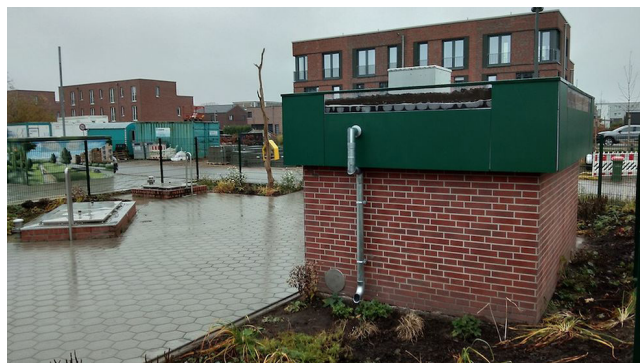
Telhado verde-azul inteligente em Hamburgo (© BA Harburg)
